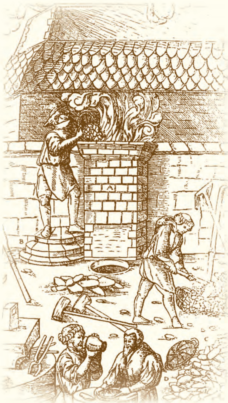
Закрытая шахта штукофена хорошо концентрировала тепло
