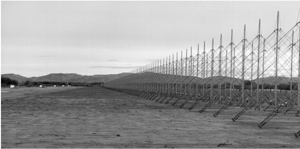
Рис. 1.9. Приемная антенна ЗГ РЛС Jindalee. Приемная антенна состоит из однородного линейного массива 462 элементов с вертикальной поляризацией спаренных верных антенн. Апертура приемной антенны имеет длину приблизительно 2,8 км. © Commonwealth of Australia 2011
