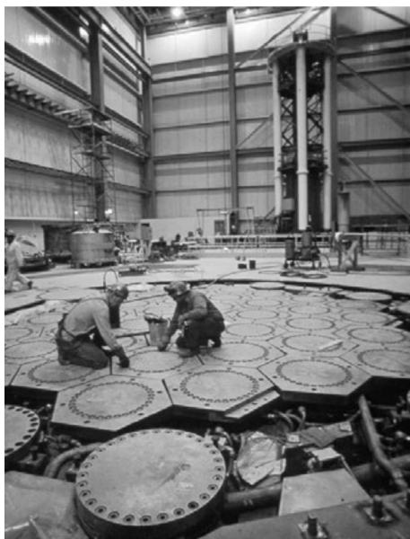
Рис. 1.1. Укладка топливных элементов на АЭС Fort St. Vrain (см. цв. вклейку)
