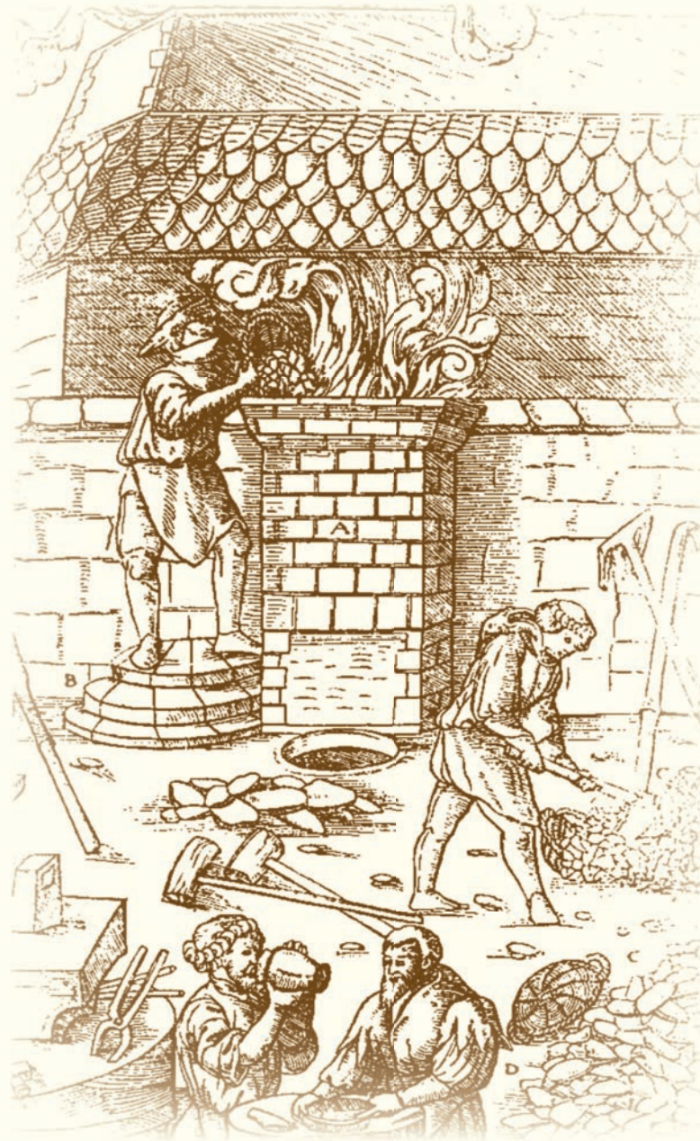
Закрытая шахта штукофена хорошо концентрировала тепло
