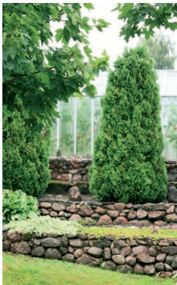
Подпорные стенки из валунов на цементной стяжке
