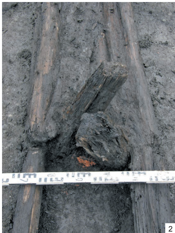
Рис. 26. Набережная. Раскоп 3. 2-й строительный горизонт: 1 – дренажный желоб – общий вид с запада; 2 – дренажный желоб, деталь конструкции – крепеж и стыковка продольных лаг желоба
