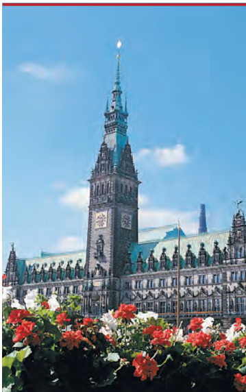
4000 дубовых свай понадобились для строительства новой ратуши
