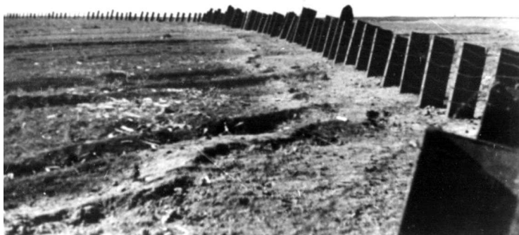
Советские «зубы дракона» на Перекопе: противотанковые надолбы из стальных балок (NARA).
