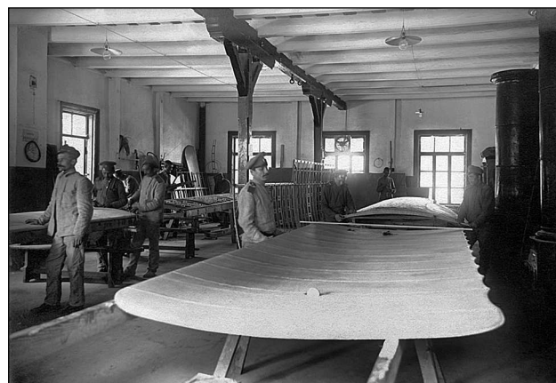
Обтянутое тканью крыло после пропитки несколькими слоями аэролака приобретало гладкую поверхность кремового или желтоватого оттенка
