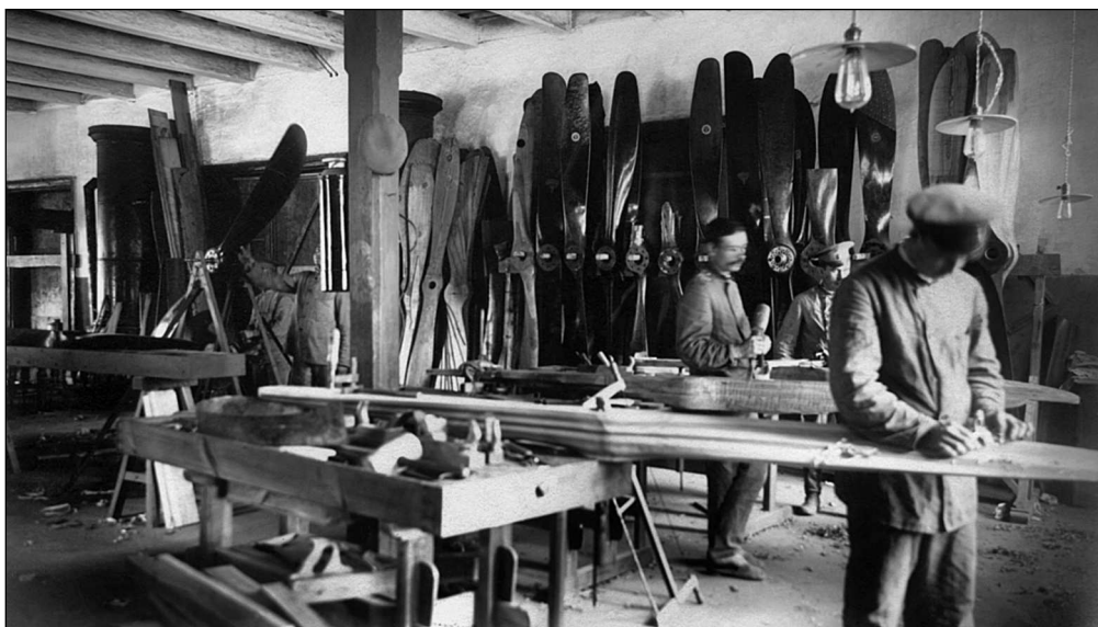
Ремонт и изготовление деревянных воздушных винтов в 6-м авиапарке. На переднем плане мастер проверяет точность профиля лопасти при помощи шаблона. У стены размещены воздушные винты, подготовленные к эксплуатации
