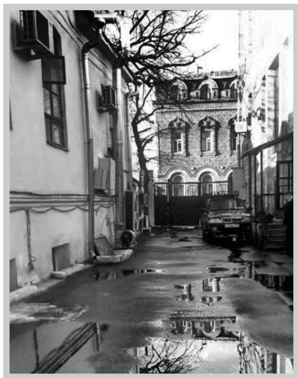
Окна нашего подвала — на уровне лужи
