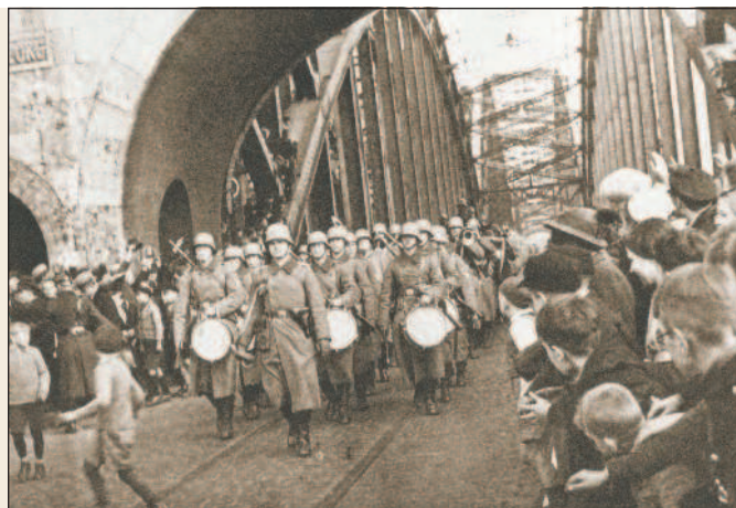
Немецкие войска маршируют через мост Гогенцоллернов — железнодорожный мост через реку Рейн. 7 марта 1936 г.
