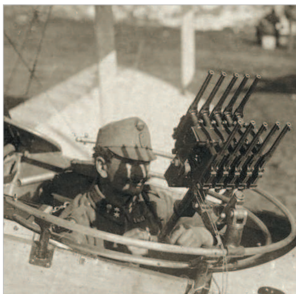
Необычное использование маузеров — пулеметная установка, созданная на основе 10 объединенных пистолетов.
