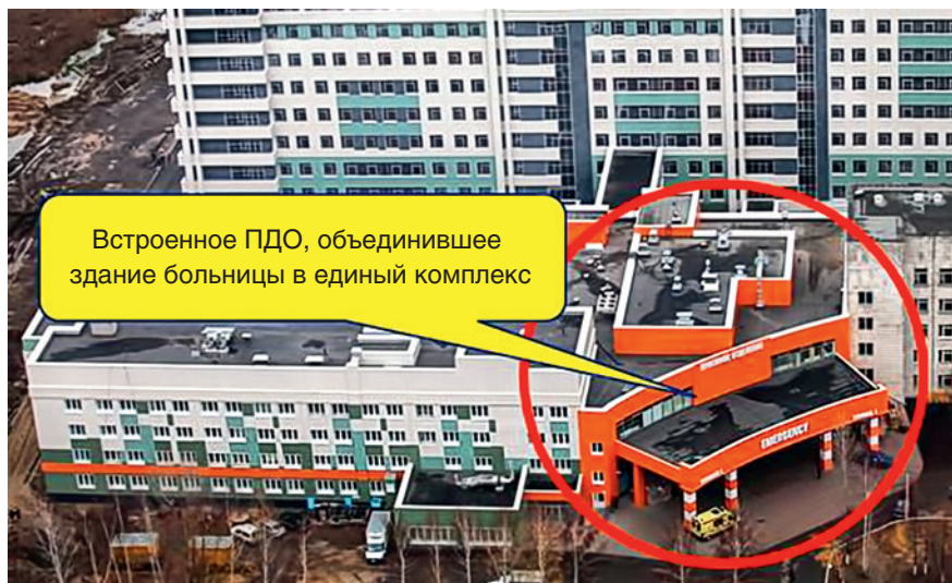
Рис. 3. Пример пристройки, где расположено приемно-диагностическое отделение (ПДО), к действующему корпусу клиники — Городская клиническая больница № 7, г. Казань (Республика Татарстан, РФ)
