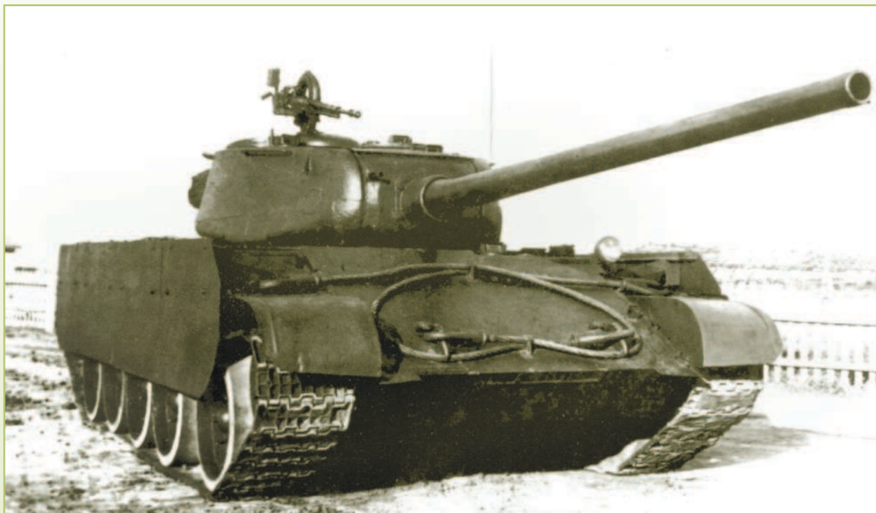
Танк Т-44-100, вооруженный 100-мм пушкой Д-10Т. Осень 1945 года
