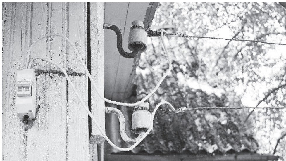
Рис 1.7. Ввод электричества в деревянный дом
