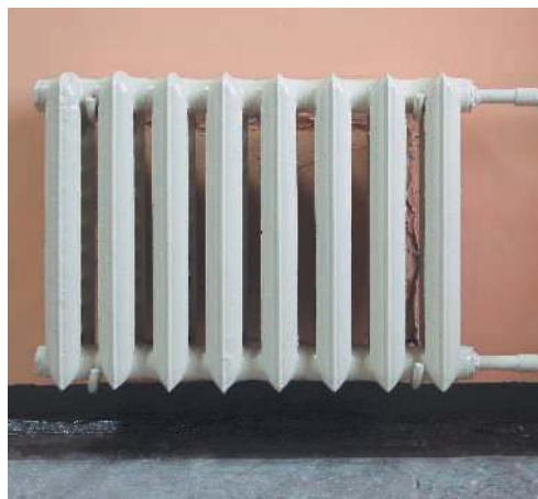
Рис. 1.10. Вода является основным теплоносителем, используемым в радиаторах
