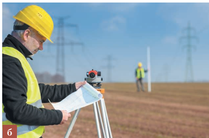
Рис. 1.6. Геодезический вынос: а — работа геодезиста; б — геодезический вынос участка и закрепление границ
