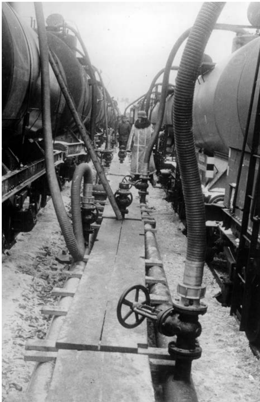
Перекачка нефти из советского эшелона в немецкий на пограничной станции в городе Перемышль (1940 год).
