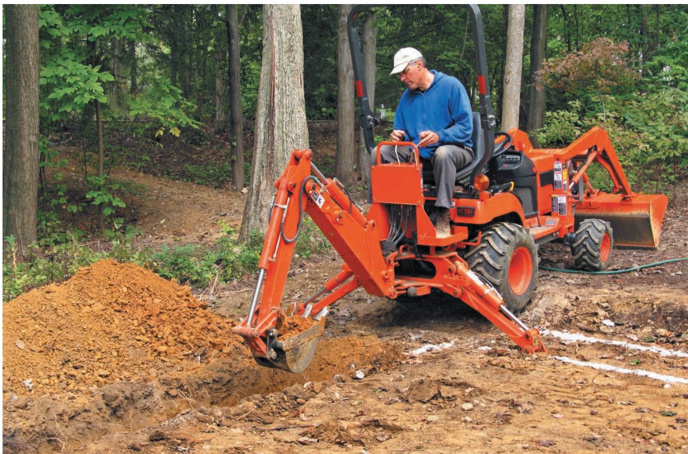
Рис. 2.3. Котлованы рыть лучше с помощью специальной техники
