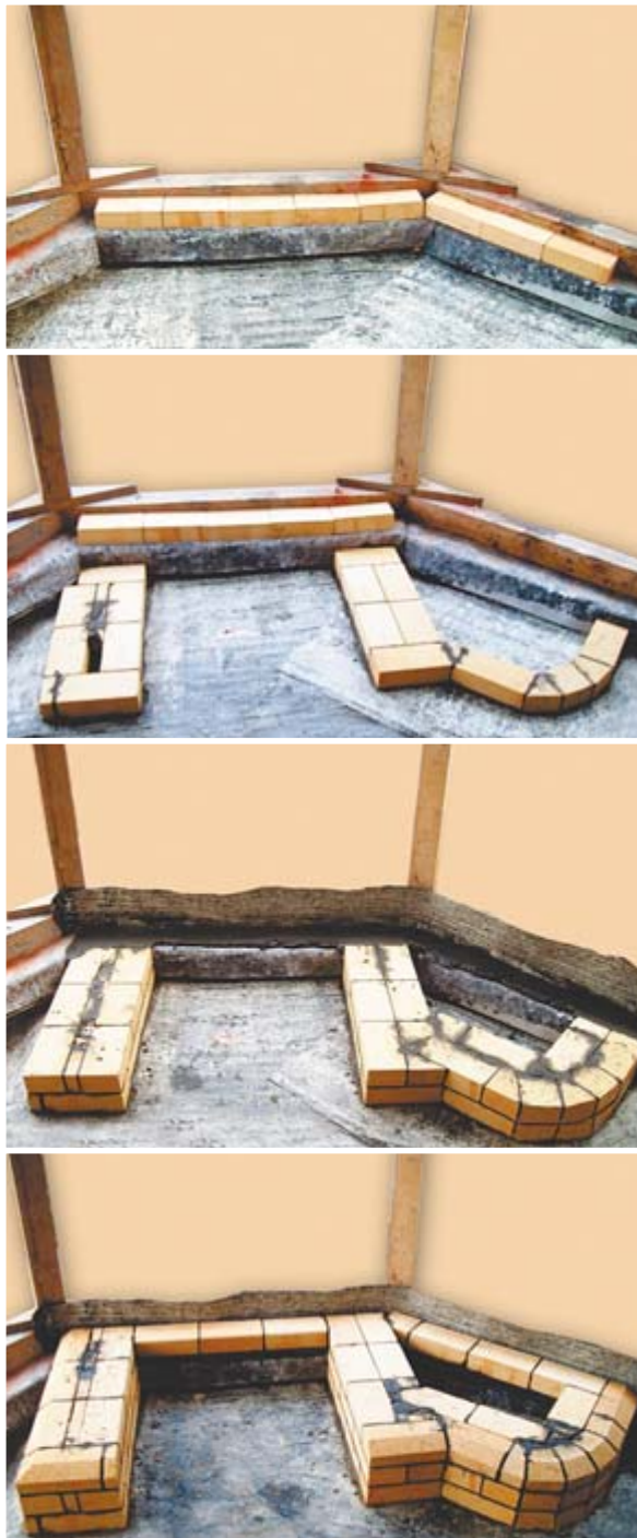
Рис. 9.2. Устройство гидроизоляции фундамента отдельно стоящего камина
