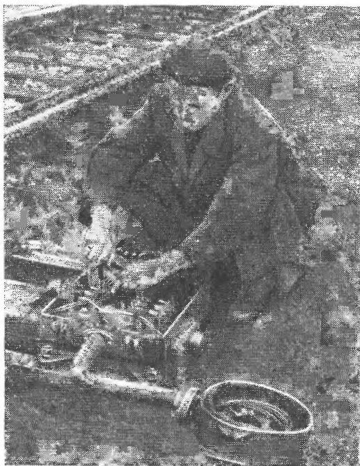
Электромеханик дорожной лаборатории связи В. С. Довнич проверяет монтаж электропривода СП-1
