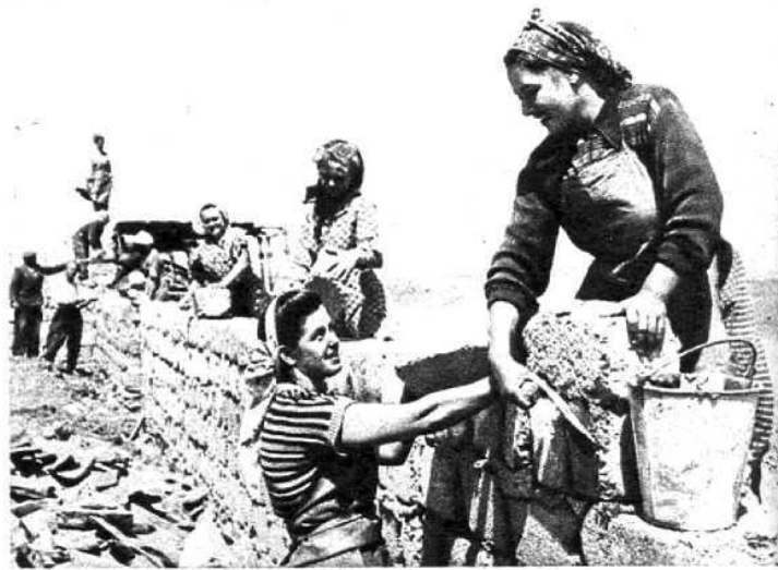
На строительстве атбасарского зернохранилища работают две подружки-комсомолки — Ирина Польший из Кривого Рога (справа) и Раиса Тищенко из Днепрпетровска.
