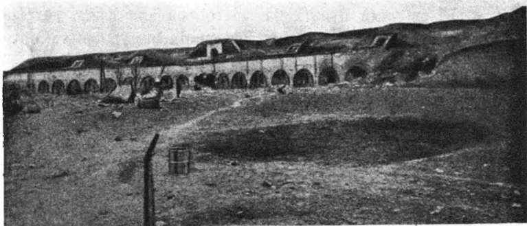
Фиг. 6. Горжевая казарма одного изъ главныхъ фортвъ съ казематированными траверсами надъ ней.
