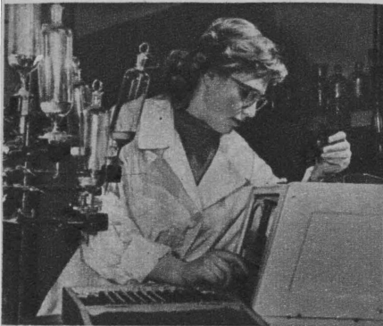
Насыщенность муки витаминами определяют с помощью флуорометра
