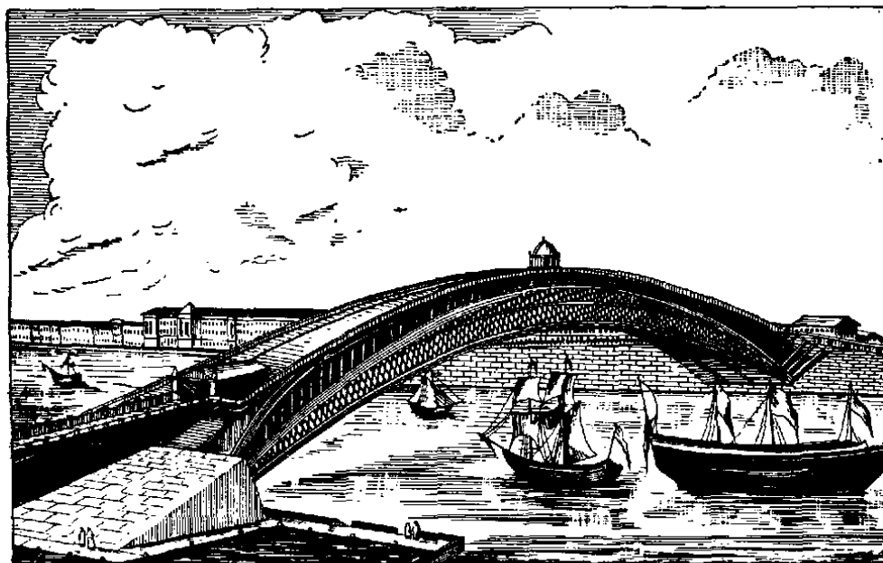
Рис. 16. Проект деревянного арочного моста, составленный Кулибиным
