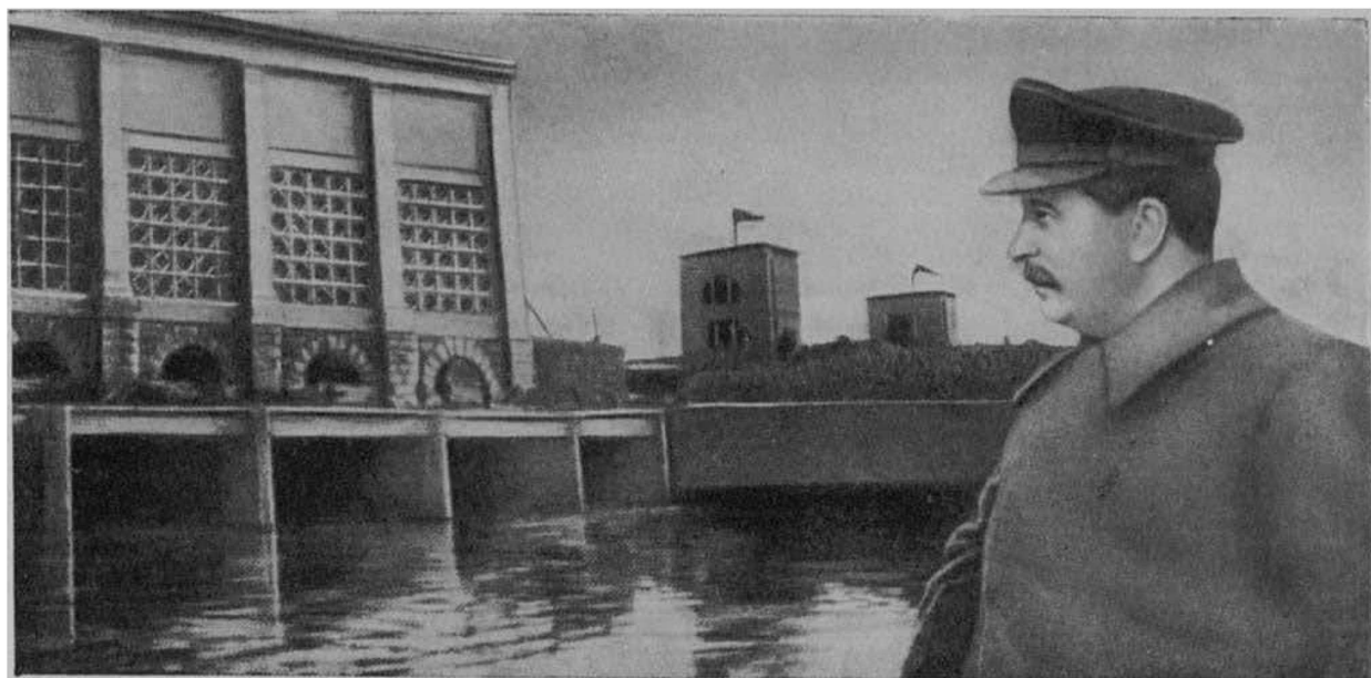
Товарищ Сталин осматривает Яхромскую насосную станцию на канале Москва-Волга
