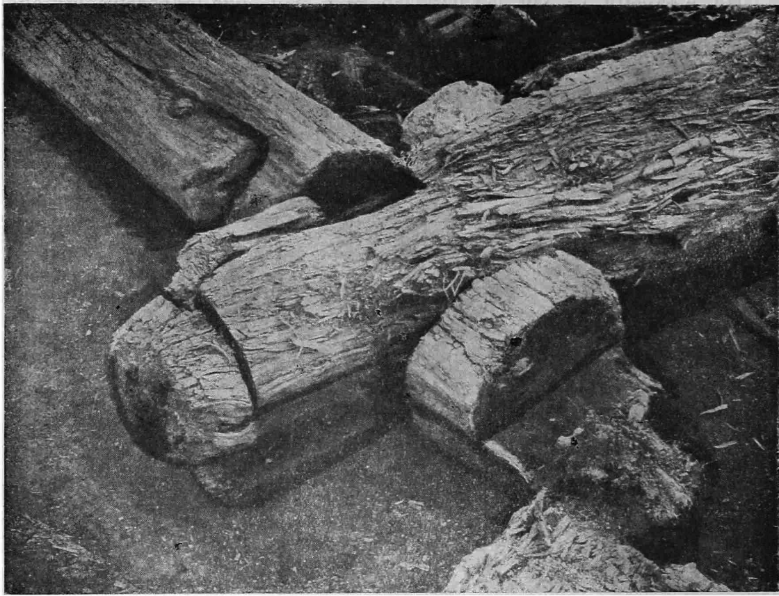
Рис. 7. Нижний венец сруба большого жилого дома из горизонта e_1 (способ рубки угла).
