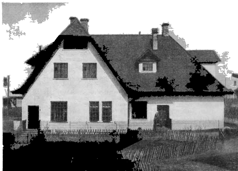
Дом жил.-стр. кооператива рабочих авто-завода ДУКС (Москва).
