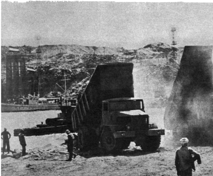
Штурм прорыва на строительстве Асуанской плотины начался. «МАЗы» сбрасывают камни в воды Нила.
