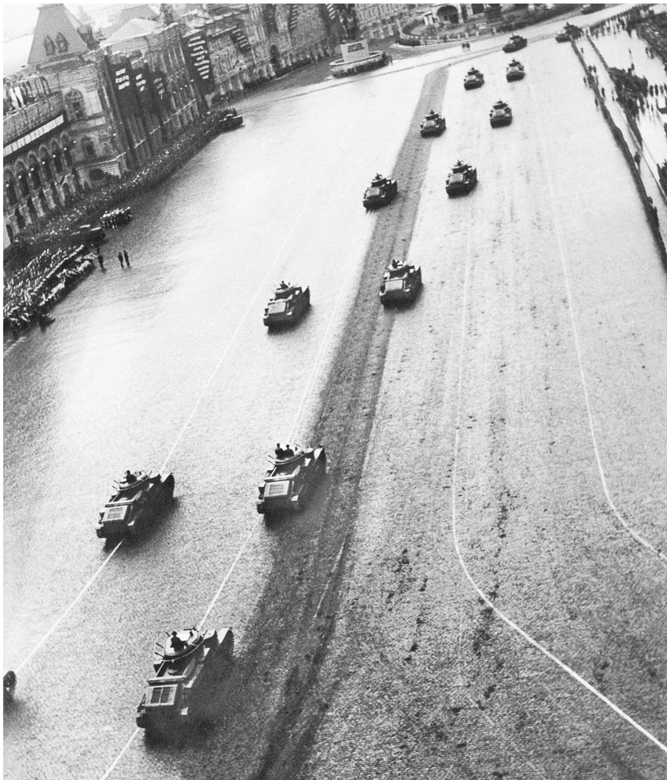
Танки Т-28 проходят по Красной площади во время парада. 1 мая 1938 года. На фото видны машины разных годов выпуска: с одним и двумя люками в главной башне, с одностворчатым и двухстворчатыми люками с жалюзи в колпаке над вентилятором, Нижний танк на фото прошел ремонт – он имеет один люк в башне, а колпак над вентилятором – двухстворчатый люк с жалюзи, открывающийся в стороны (РГАКФД).
