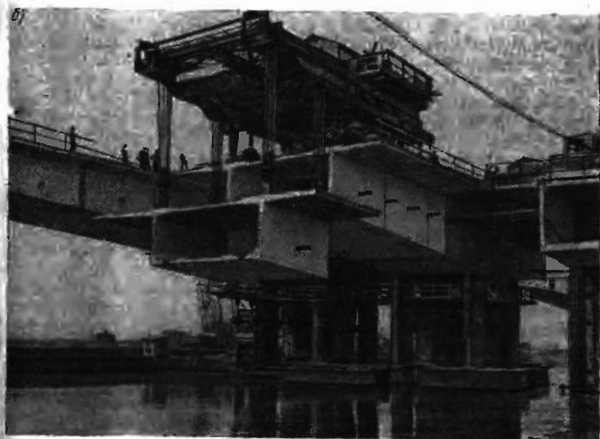
Рис. 1.1. Навесной монтаж железобетонных пролетных строений: а — моста через р. Волгу, рамно-консольного с пролетами по 118 м; б — через р. Москву, балочно-неразрезного с пролетами по 117 м
