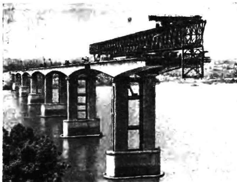
Рис. 14 Монтаж перекрестных пролетных стропил пролетом по 128 и 60 тонн краном
