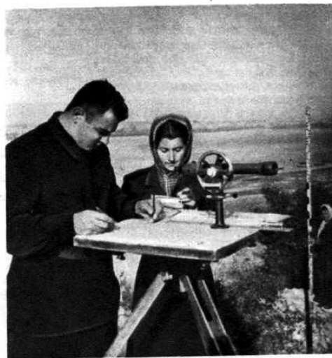
Сотни гидрогеологов ведут в районе строительства всесторонние геологические изыскания. На снимке: старший топограф В. Сизанчук и вычислитель комсомолка Л. Кравцова проводят топографическую съёмку.
