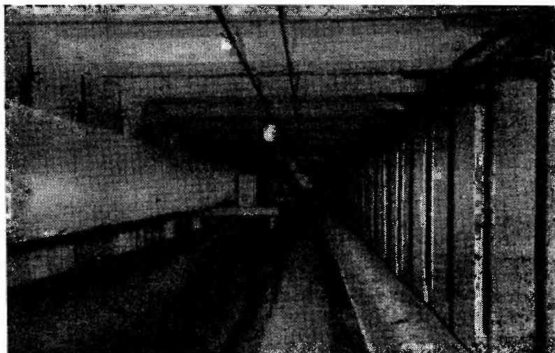
Рис. I.2. Внутренний вид общего коллектора
