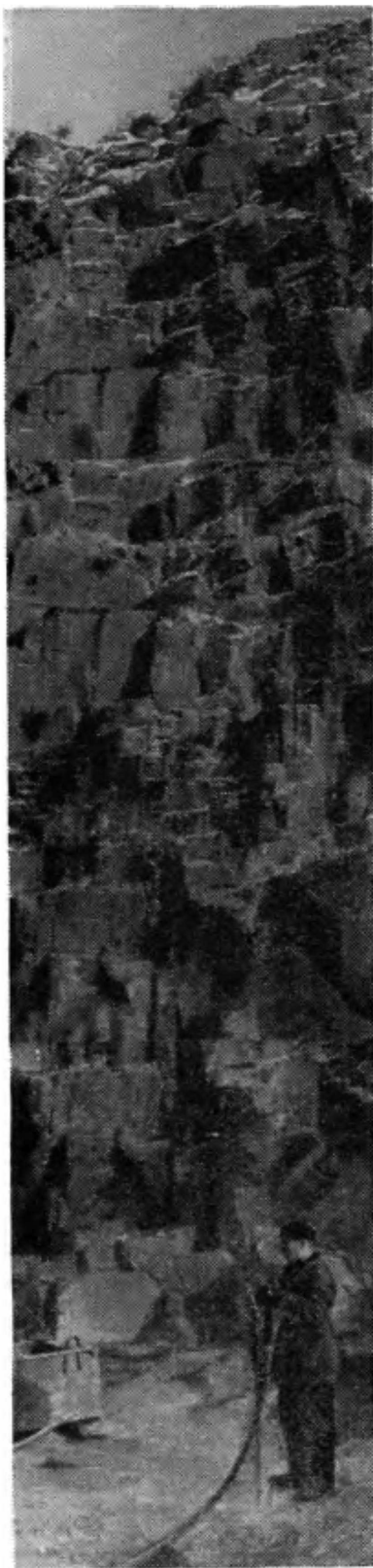
Так готовится диабазовое основание под плотину.
