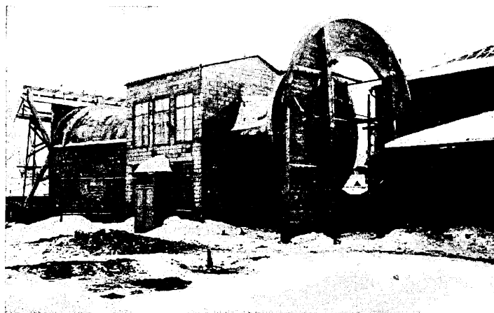
Фиг. 3. Большая бетонная труба с диаметром рабочей части в 3 метра; находится во дворе МВТУ.
