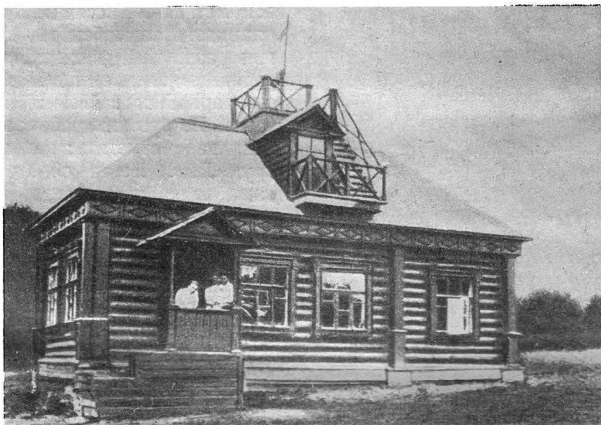
Гидробиологическая станция на Глубоком озере.
