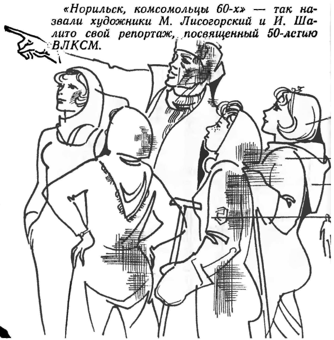
Студентки на строительстве ТЭС-2
