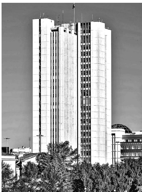
Здание Свердловского обкома КПСС
