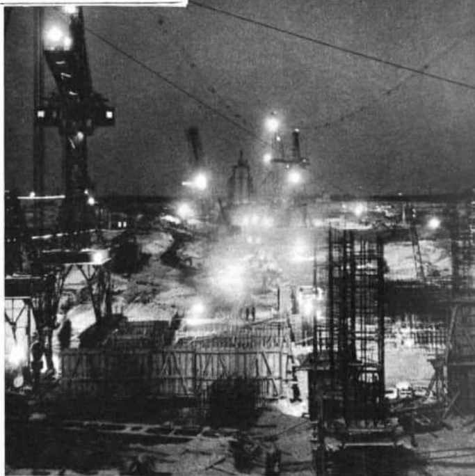
Почью в котловане.
