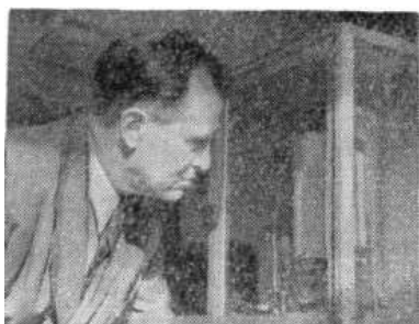
Лауреат Сталинской премии, профессор Ф. Ф. Губин в лаборатории института наблюдает за работой модели уравнительных резервуаров гидроэлектростанции.
