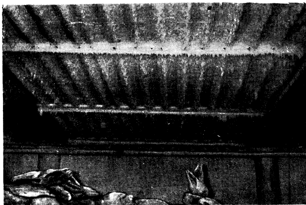
Вид камеры Сочинского холодильника, оборудованной панельными батареями: a — в начале пуска системы; б — в процессе эксплуатации
