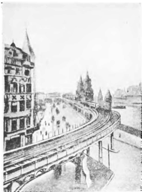
Рис. 2. Эстакада берлинского метрополитена.
