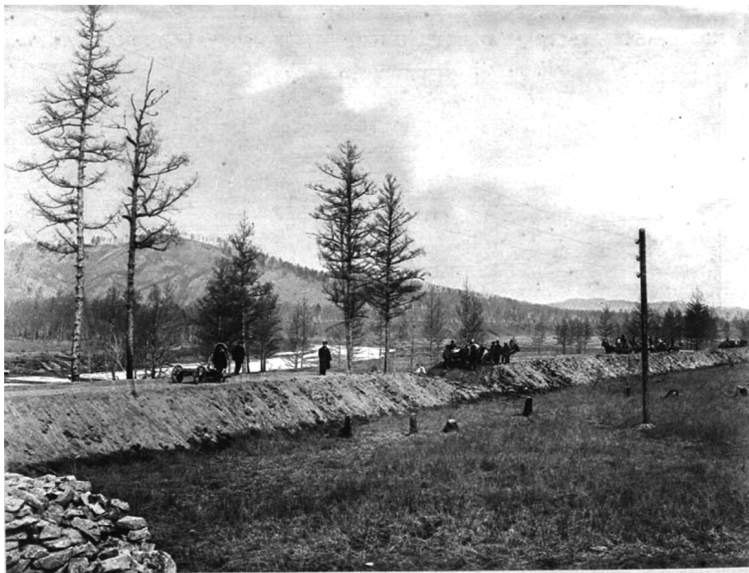
ЗЕМЛЯНЫЕ РАБОТЫ НАСЫПИ. ВЕРСТА 9-Я ПИКЕТЪ № 73-76.
