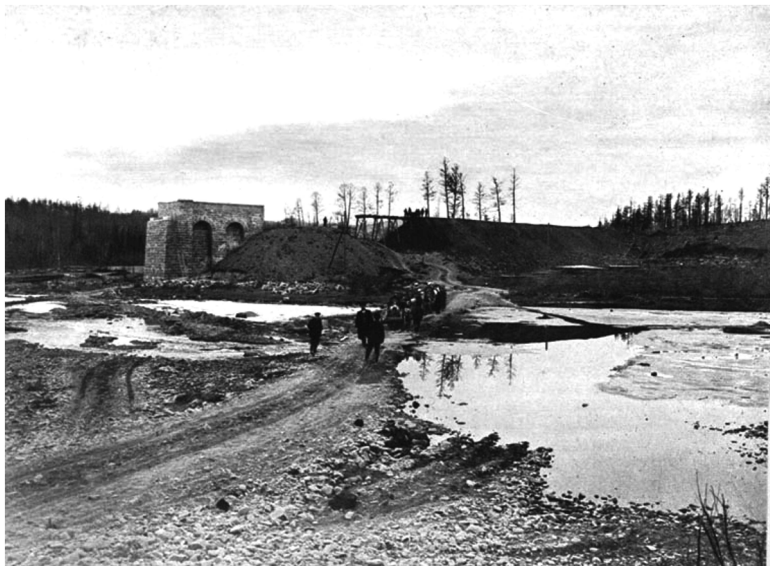
ВОСКА ЗЕМЛИ ИЗЪ РЕЗЕРВОВЪ НА НАСЫПЬ ЧЕРЕЗЪ РУСЛО РЪКИ ВЪ ЛЬДЪЙ УРЮМЪ ВЪ ПЕРИОДЪ ЕЯ МЕЛКОВОДЬЯ. ВЕРСТА 15-Я.
