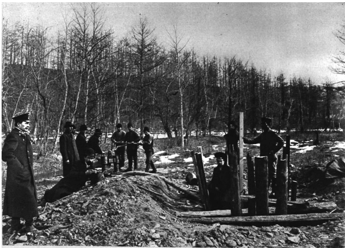
ИЗЫСКАНИЕ ВОДОСНАБЖЕНИЯ. ПОВЕРОЧИМЫЕ ИСПЫТАНИЯ ПРИТОКА ВОДЫ ВЪ ШУРФАХЪ ПРИ ИЗЫСКАНИИ ВОДОСНАБЖЕНИЯ ПО РЪКЪ БЪЛЫЙ УРЪМЪ ПРИ СТАНЦИИ „УРЪМЪ“. ВЕРСТА 1-Я
