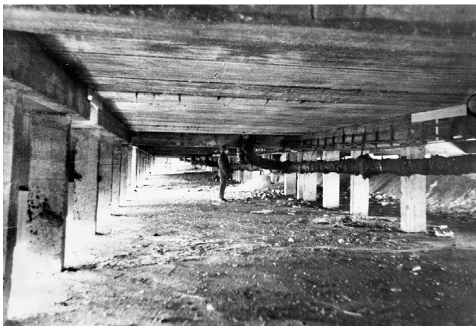
Рис. 1. - Проветриваемое подполье в жилом доме
