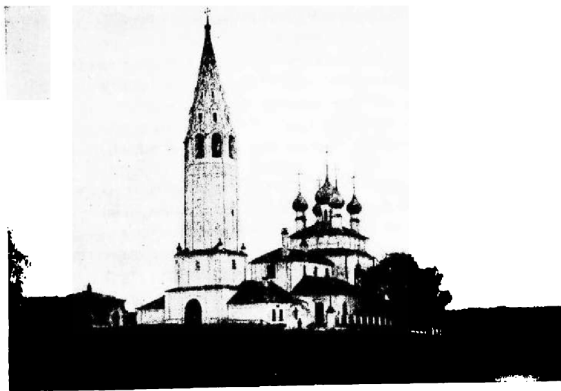
2. Палехская церковь с юго-запада.
