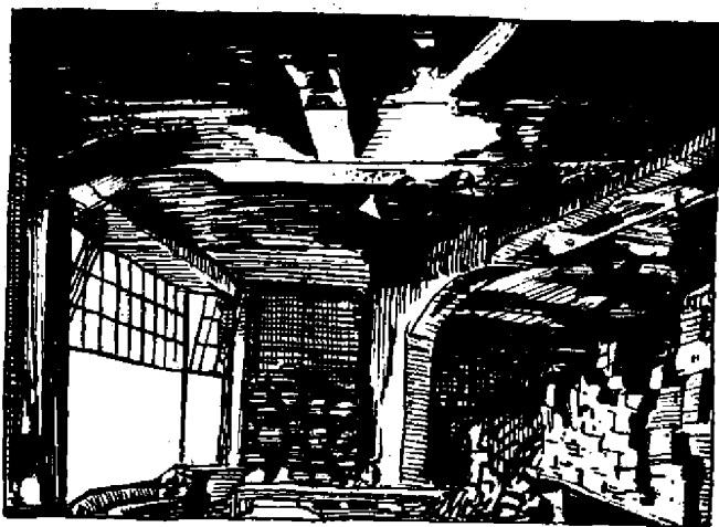
Фиг. 9. Вид жел.-бет. потолка в здании Эсдере в Дрездене после пожара. Белые пятна след струи пожарного насоса.
