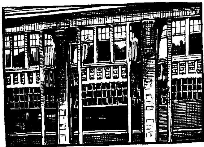
Фиг. 8. Железо-бетонный корпус фирмы Эсдере в Дрездене после пожара 1911 г.
